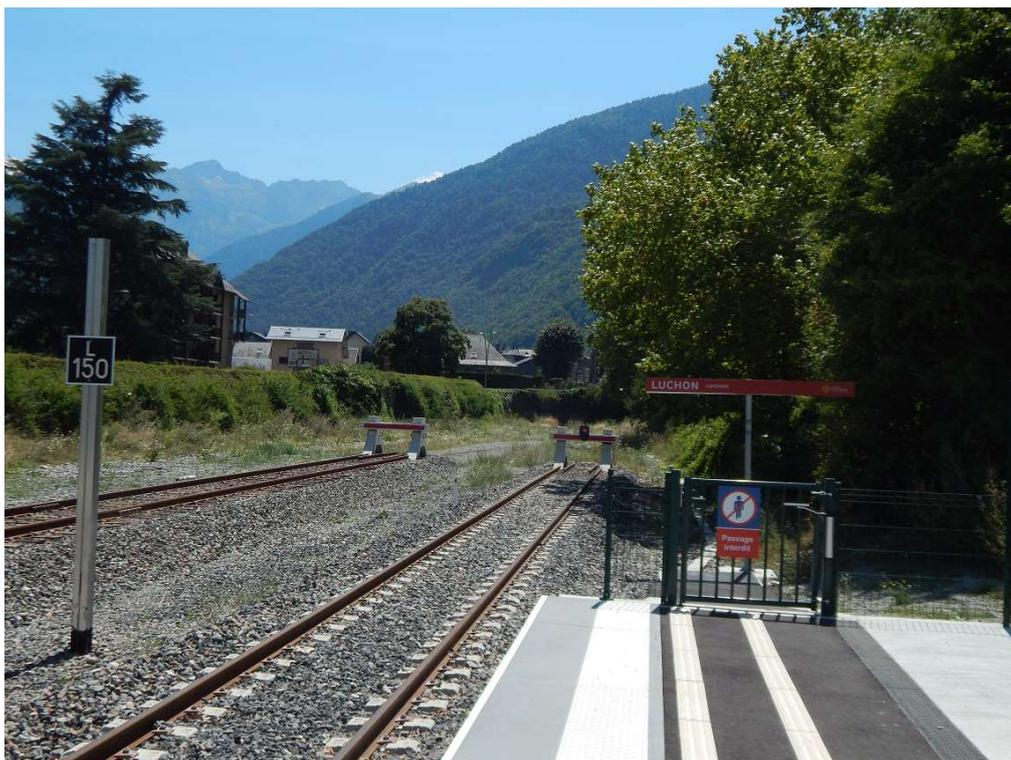
Les quatre gares sont toutes équipées de panneaux [L90] et [L150] pour les points d'arrêt , ou [TT] dans le sens Nord > Sud pour les trois haltes intermédiaires. Les quais, Luchon comprise, font tous 149 m (une composition Regiolis en UM a une longueur de 144 m) :
